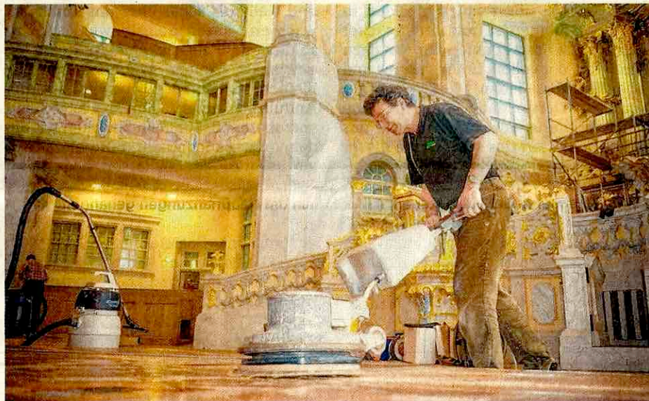
Johannes Fliegel reinigt den Holzfußboden mit einer Tellerschleifmaschine. Die Tischlerei des 52-Jährigen ist eine von knapp 20 Firmen, welche die Frauenkirche aufmöbeln.
