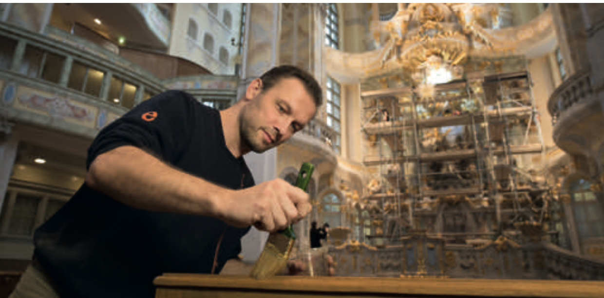
Der Auftrag von Beizu und Öl schützt das Holz.
