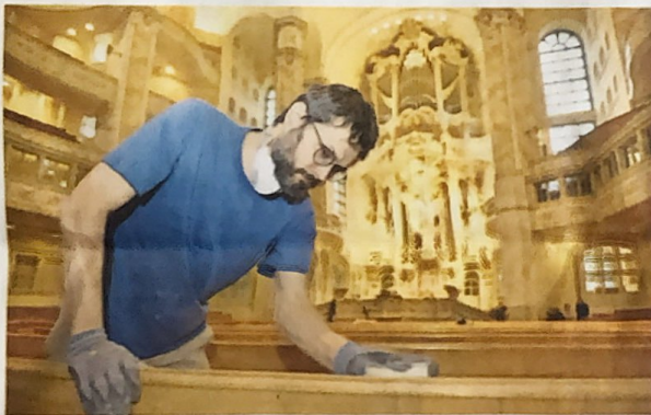
Michael Huth vom Atelier Sinnesmagnet schleift abgenutzte Stellen des Gestühls ab. Danach wird es gereinigt, gebeizt und gewachst.
